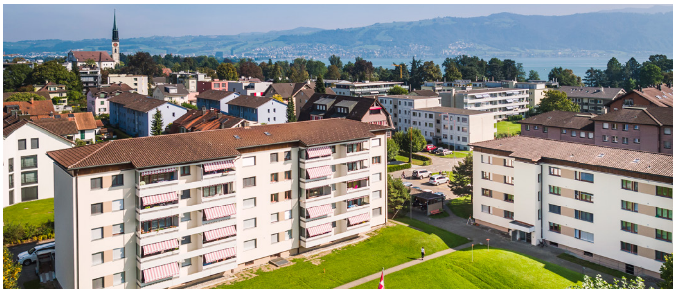
Blick auf die sanierten Fassaden. Der geplante Eckbau soll die Lücke zwischen den beiden Häusern schliessen.
